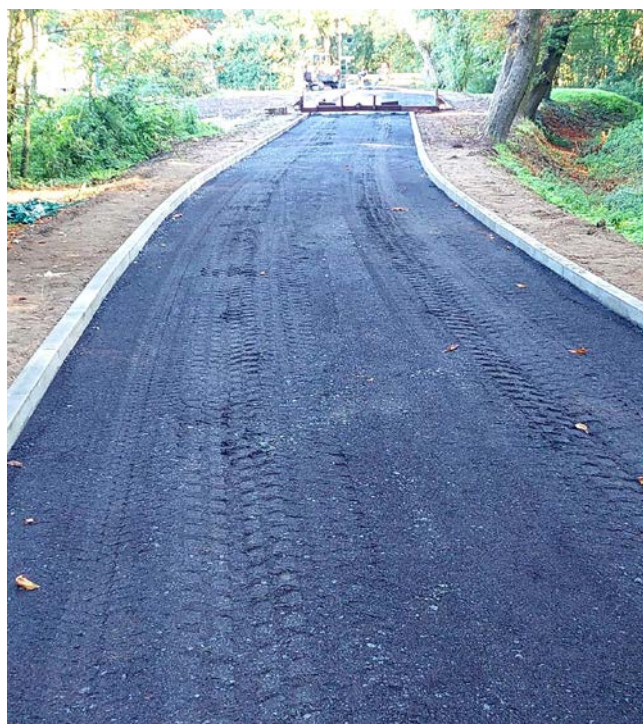
Przebudowa ul. Parkowej od strony ul. Zamkowej - 22.09.2022.
