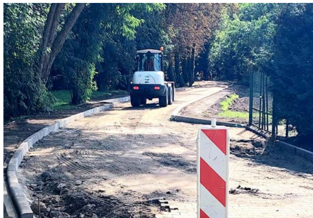
Przebudowa ul. Parkowej od strony ul. Zamkowej
