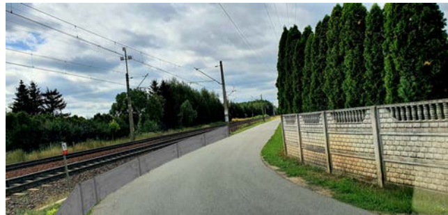
ul. Parkowa od strony ul. Herbowej z barierą betonową
