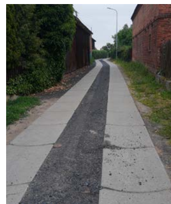
Brudzewo - droga z betonowych płyt
