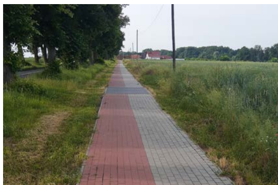
Myszęcín - Szczaniec - ścieżka rowerowa z betonowej kostki brukowej II
