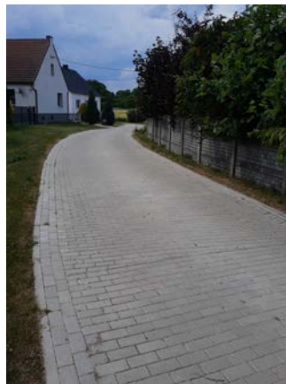
Wolimirzyce - droga z betonowej kostki brukowej (odcinek za remizą OSP)
