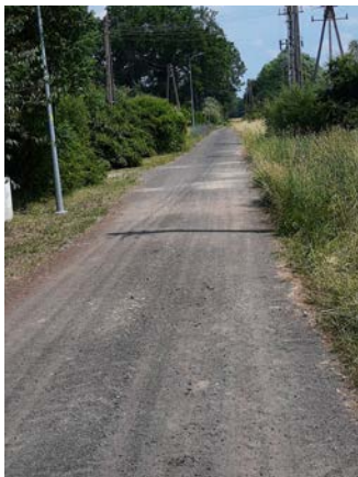
Wilenko - Kolonia - droga z frezownicy asfaltowej
