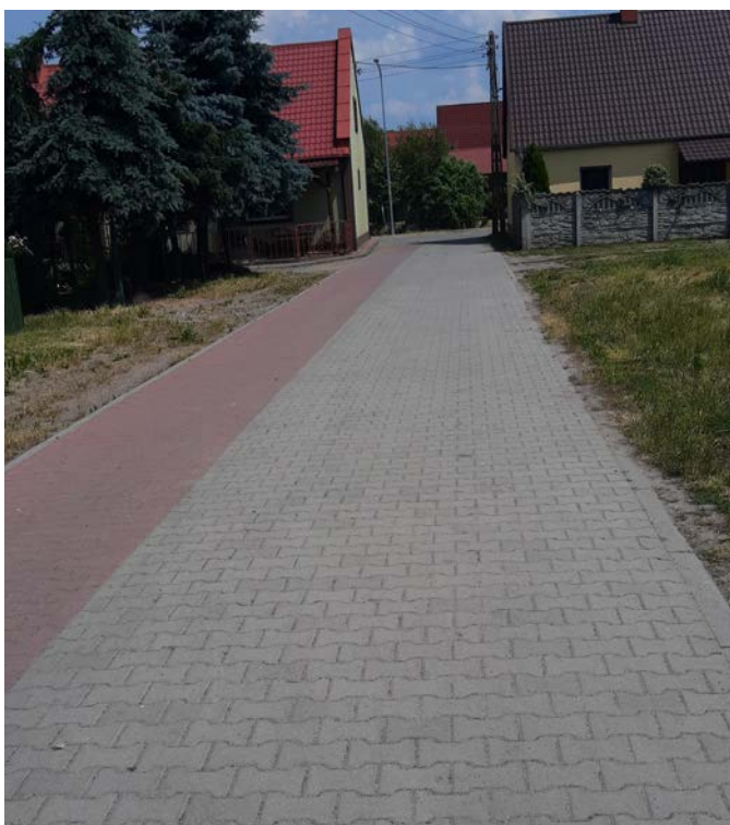
Szczaniec - droga z betonowej kostki brukowej (ul. św. Anny)
