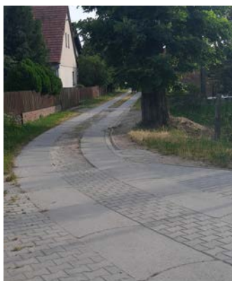
Myszęcin - droga z płyt betonowych II
