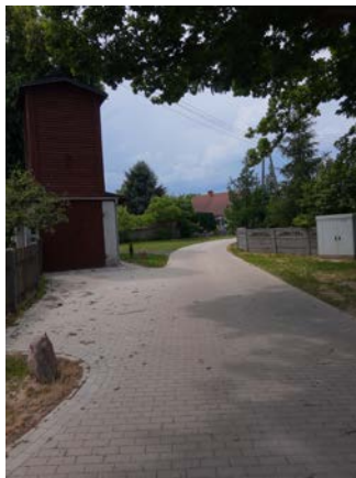
Wolimirzyce - droga z betonowej kostki brukowej (koło remizy OSP)
