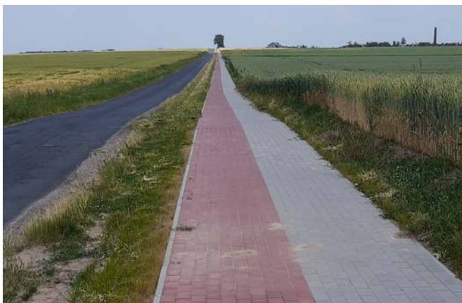
Szczaniec - Ojerzyce - Kupienino - ścieżka rowerowa z betonowej kostki brukowej
