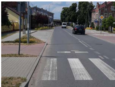
Szczaniec - droga asfaltowa z chodnikami (ul. Herbowa dr. powiatowa)
