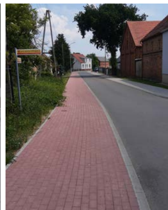
Szczaniec - droga asfaltowa ze ścieżką rowerową i chodnikiem (ul. A. Asnyka)
