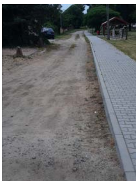
Ojczyce - chodnik z betonowej kostki brukowej za remizą OSP
