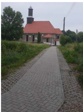
Smardzewo - trakt pieszo jezdny z betonowej kostki brukowej i płyt azulejowych (droga do kościoła)
