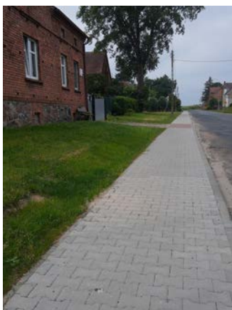
Opalewo - chodnik z betonowej kostki brukowej II
