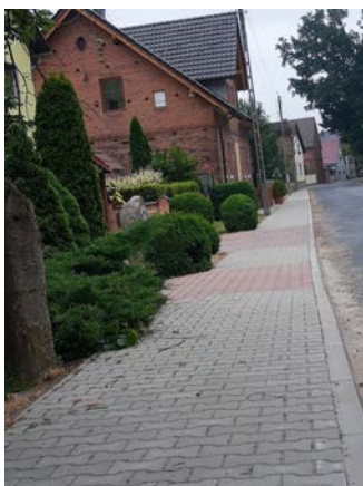
Opalewo - chodnik z betonowej kostki brukowej I
