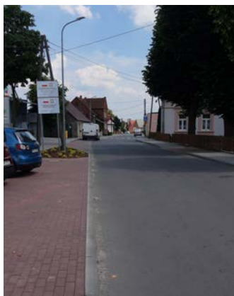
Szczaniec - droga asfaltowa z chodnikami i parkingami (ul. Szkolna)
