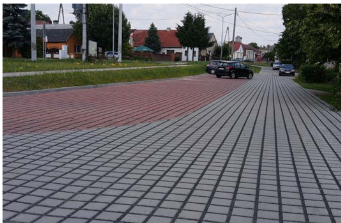
Myszęcin - droga i parking z betonowej ekokostki (koło kościoła)
