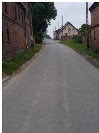
Dąbrówka Mała - droga asfaltowa
